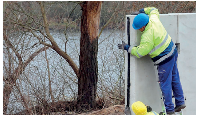
Самоклеящаяся лента RubberElast® внутри водозащитного ограждения в Виттенберге
