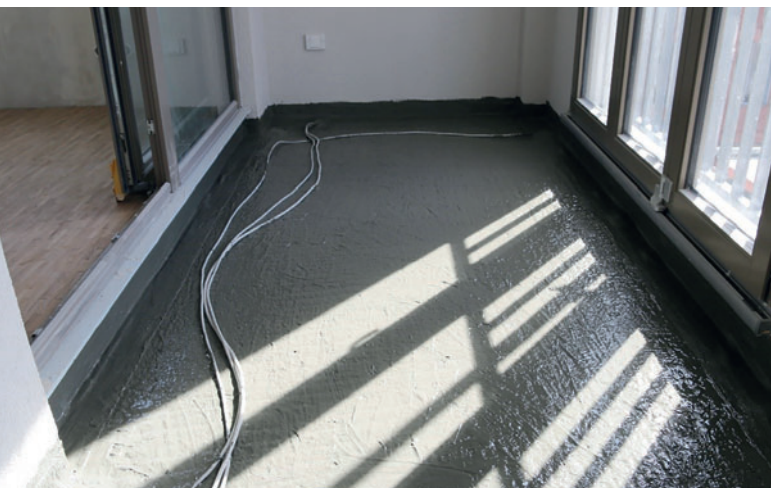
Гидроизоляция балкона с помощью системы FlächenElast®
