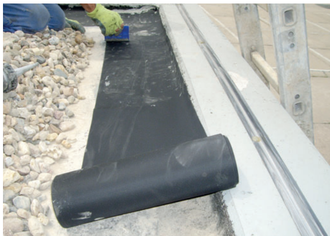
Гидроизоляция кровли с помощью системы ProElast®
