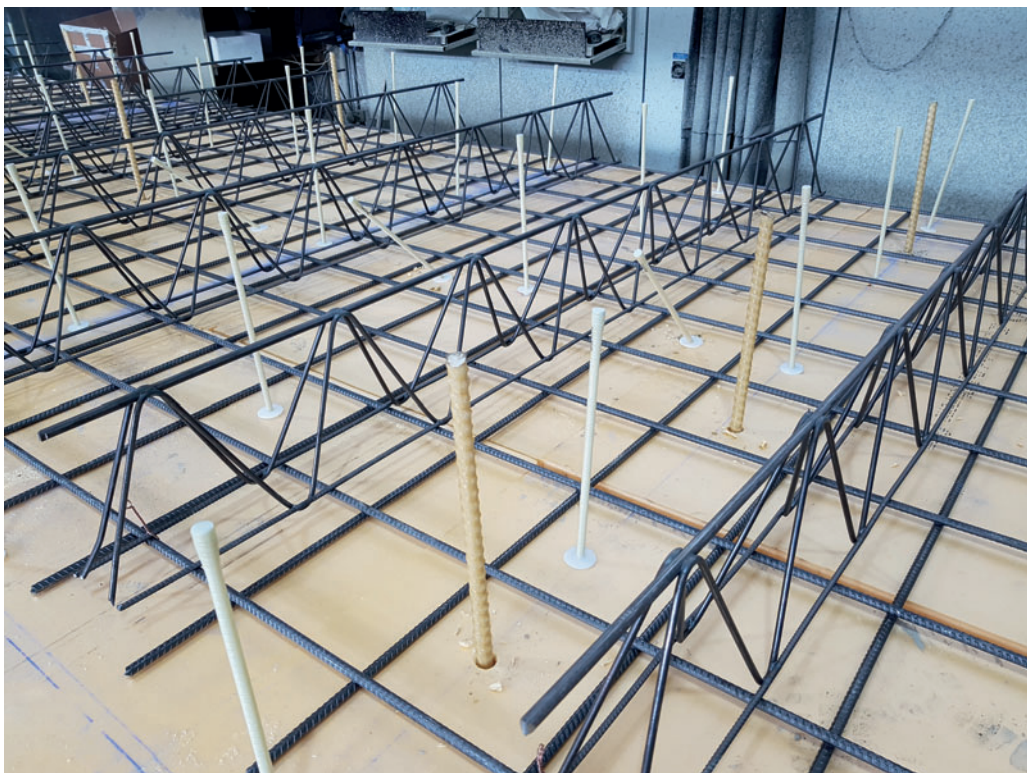
ThermoPin - Produktion einer kerngedämmten Doppelwand mit Sandwichbrüstung
