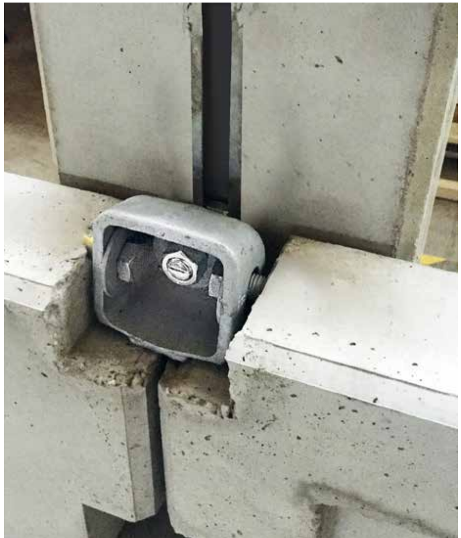
Bild 3: Das BT-Spannschloss® wurde 2019 um die Anwendung „Dreipunktverbindung“ erweitert
