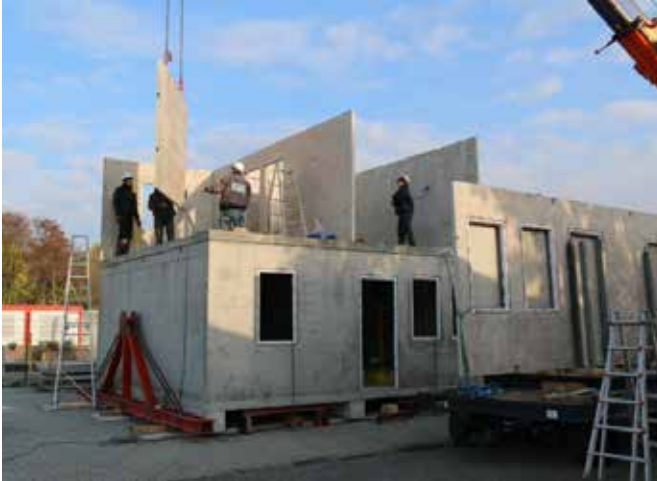
Bild 6 und 7: Das „Low Cost House“-Konzept – Innerhalb kurzer Zeit können massive Betonhäuser für die Unterbringung von Menschen in Not zur Verfügung gestellt werden
