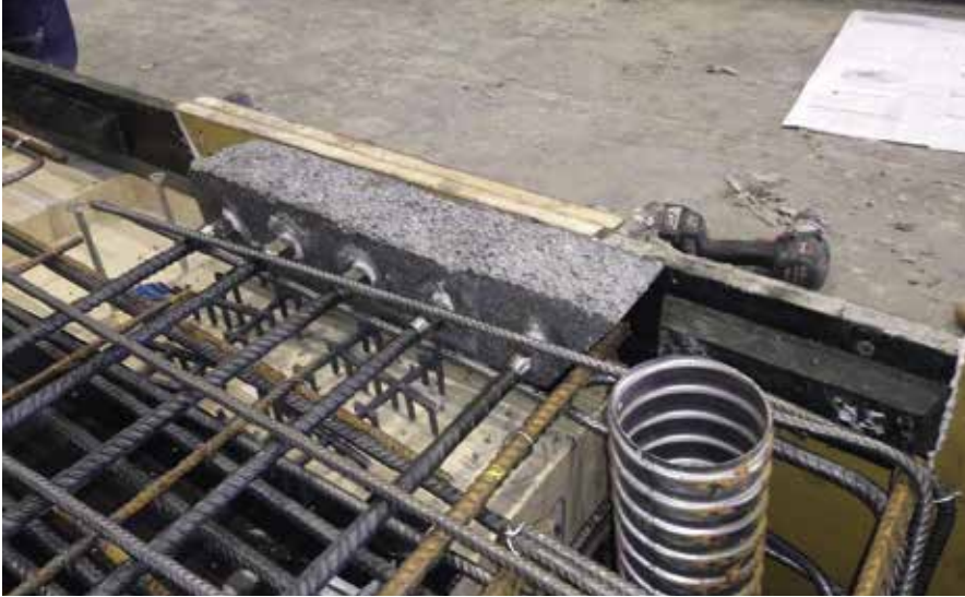
Bild 3: Seitliche Ansicht der Anschlüsse von Muffenstäben an den Einmal-Aussparungskörper
