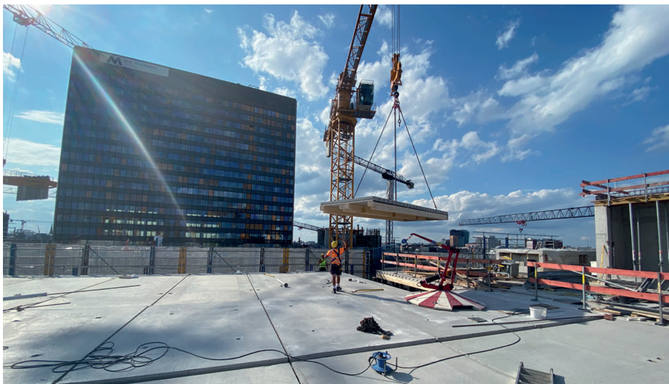
Mise en œuvre d'un plancher hybride bois-béton dans un bâtiment en construction ; en arrière-plan, la tour historique du Postscheckamt.
