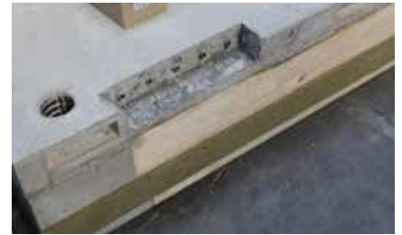
Bild 3: Ausgeschaltete Deckenplatte aus mit Aussparung für die BT-Spannschlösser
