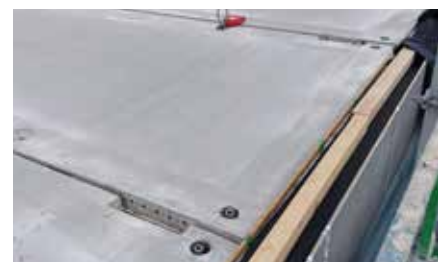
Bild 5: Verlegte Deckenplatten
