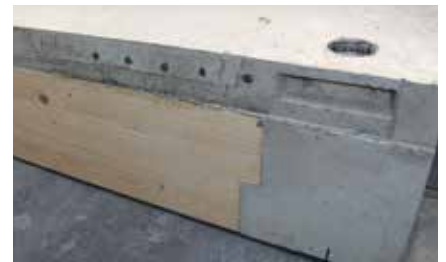
Bild 4: Anzuschließende Deckenplatte mit bündigen Schraubhülsen der Muffenstäbe
