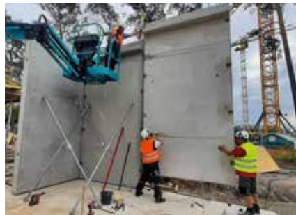
Bild 1: Wandmontage am Siemens Campus Erlangen, Verbindung der Wände mit dem BT-Spannschloss
