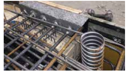
Bild 2: Seitliche Ansicht der Anschlüsse von Muffenstäben an einem Einmal-Aussparungskörper
