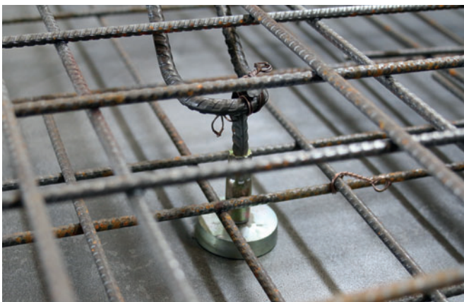
Magnet Typ GB als Ankerbefestigung im Einsatz
