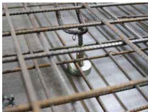
Type GB anchor fastener in use Magnet Typ GB als Ankerbefestigung im Einsatz
