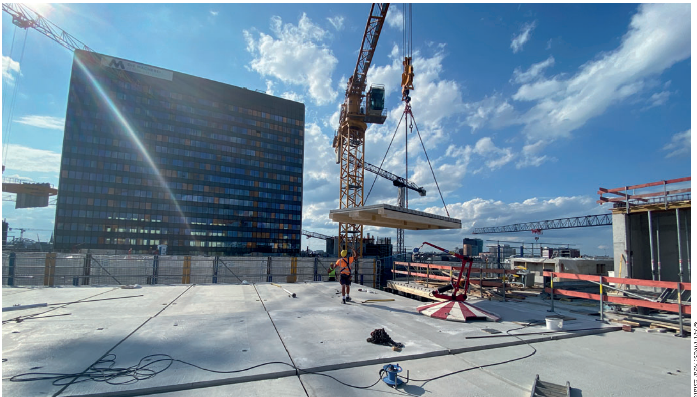
Монтаж гибридного деревобетонного перекрытия перед оригинальной башней Почтово-сберегательного банка
