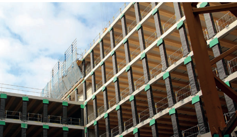
Корпус здания M40 с видом на нижнюю часть гибридных перекрытий из дерева и бетона
