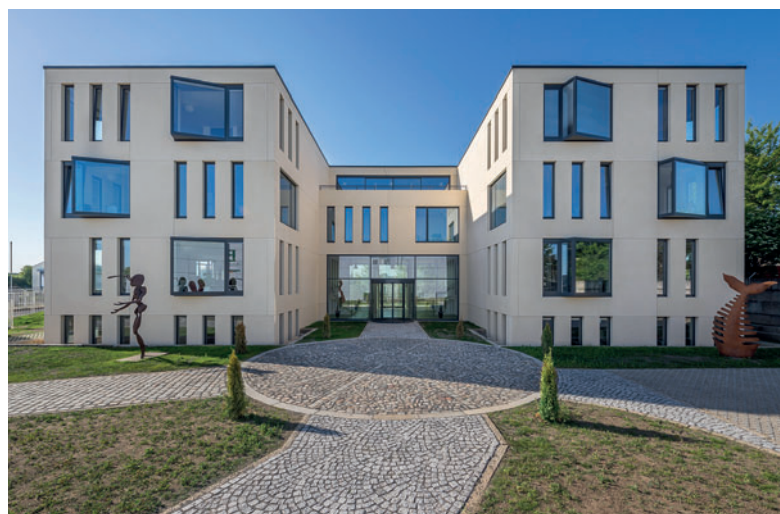
Штаб-квартира компании B.T. innovation GmbH – многослойные стены были изготовлены с использованием анкерных стержней ThermoPin
