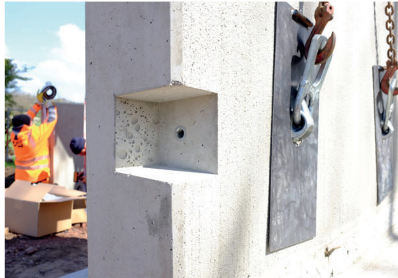
Recess for a BT-Spannschloss in the Klein Schierstedt project
