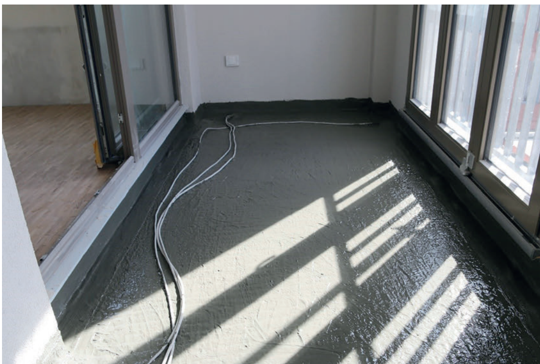
Balkonabdichtung mit FlächenElast®- System
