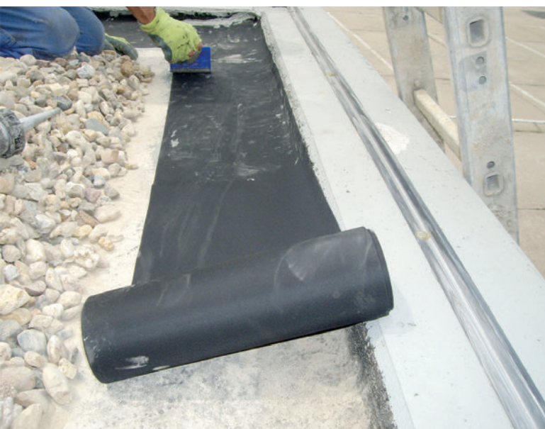
Dachabdichtung mit dem ProElast® System
