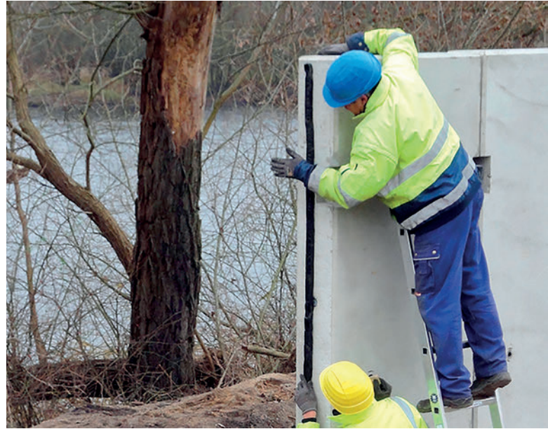
RubberElast® bei der Flutschutzwand in Wittenberge
