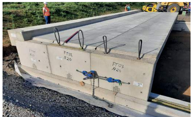
Предварительная сборка с использованием цепного подъемника
