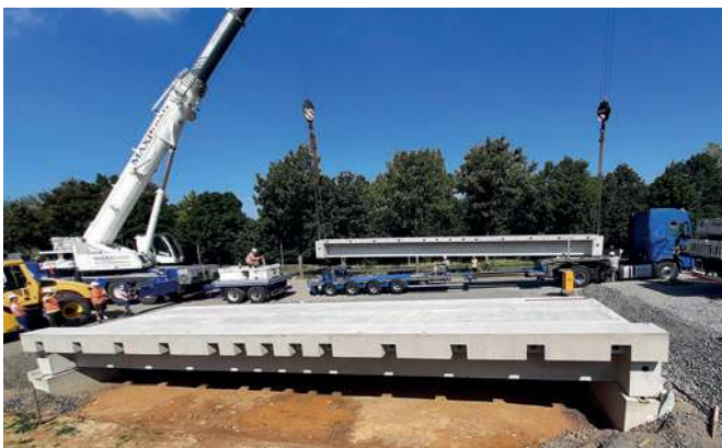
Установка следующего сборного ж/б элемента
