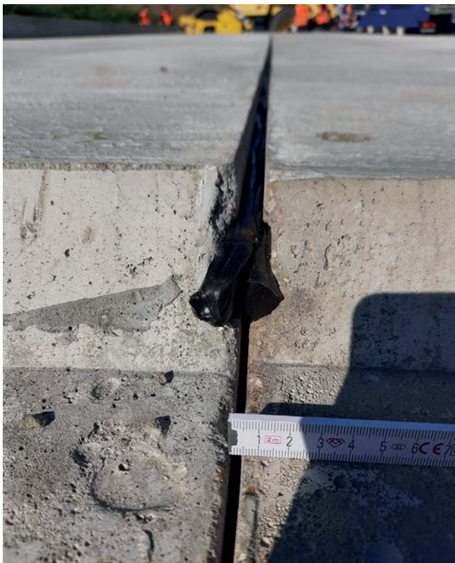
RuberElast до установки поперечной арматуры
