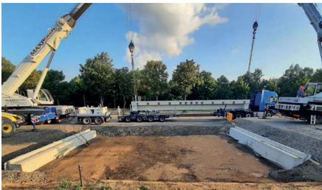
Поднятие первого сборного ж/б элемента на опоры
