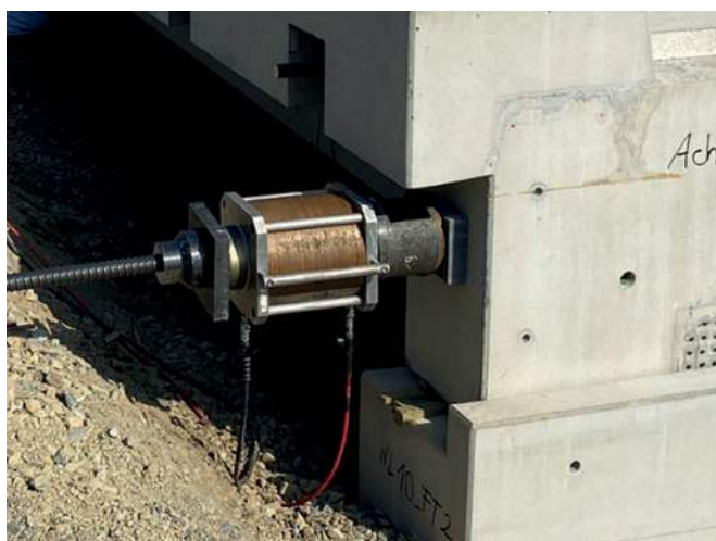
Последующее поперечное крепление
