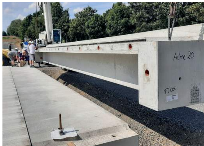
Установка последнего сборного ж/б элемента
