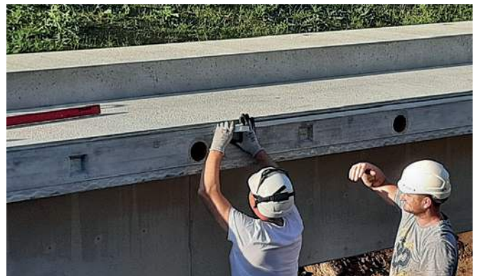
Установка прижимной ленты RubberElast
