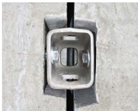
Abbildung 2: Agrar-RubberElast nach der Montage mit dem BT-Spannschloss
