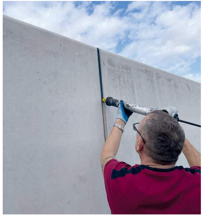
Заполнение шва герметиком AgrarElast
