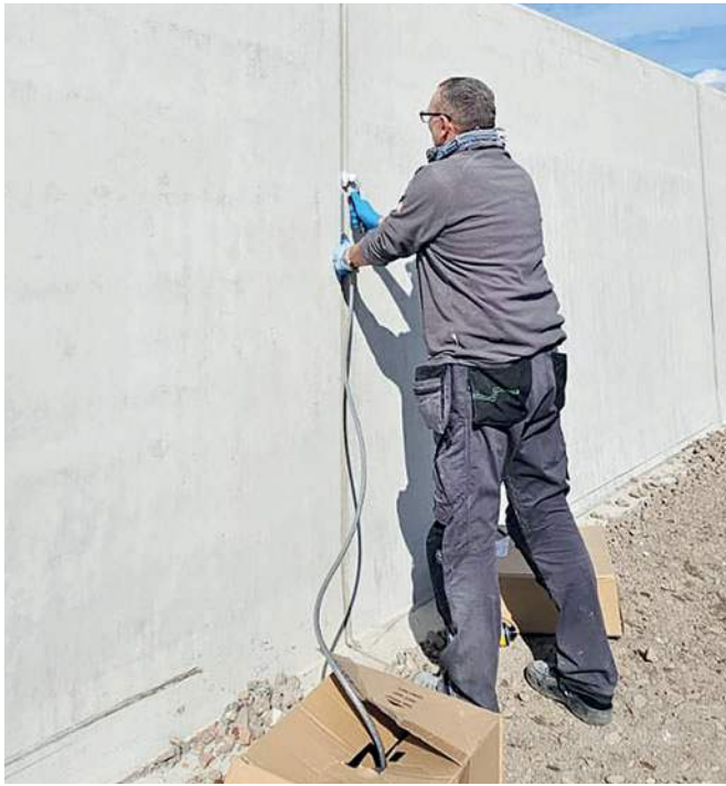
Установка закладочного шнура
