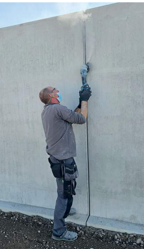
Угловая шлифовка бетонного шва
