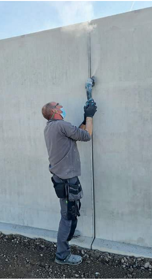
Pulido angular de la junta de hormigón
