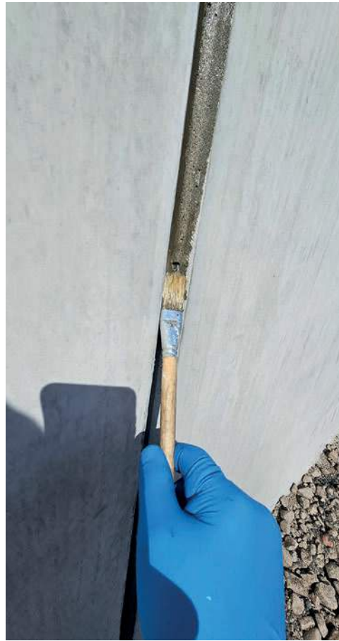
La junta es tratada con la imprimación B(eton) para hormigón
