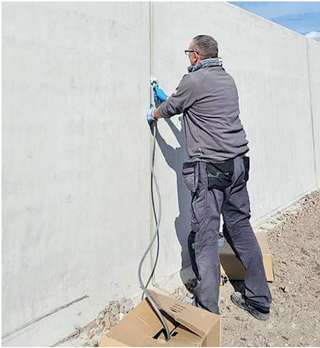
Colocación del cordón de relleno
