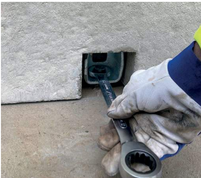
Montage des BT-Spannschlusses
