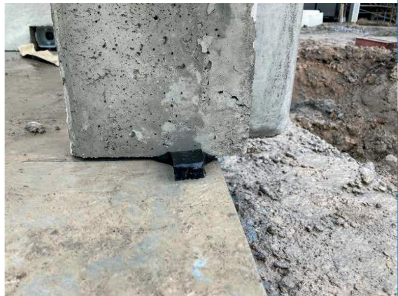
Abdichtung mit RubberElast
