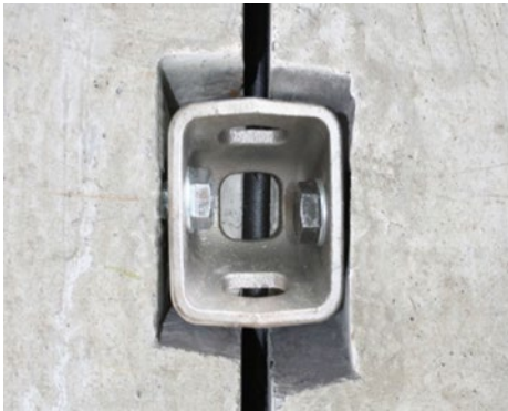
Abbildung 3: Agrar-RubberElast nach der Montage mit dem BT-Spannschloss®
