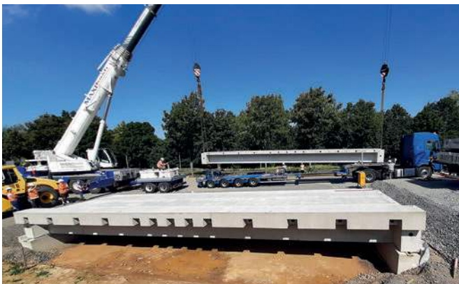
Ansetzen des nächsten Fertigteils
