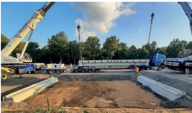
Das erste Fertigteil wird auf die Widerlager gehoben.
