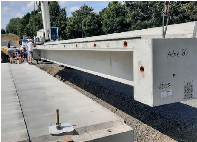
Ansetzen des letzten Fertigteils
