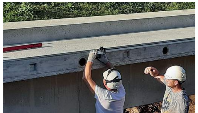
Aufkleben des Quetsch-Fugenbands RubberElast
