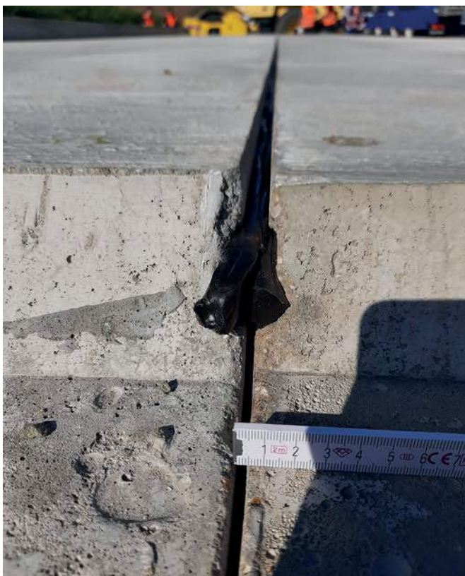
RuberElast vor der Querverspannung
