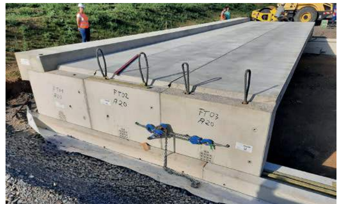
Vormontage mit Kettenzug
