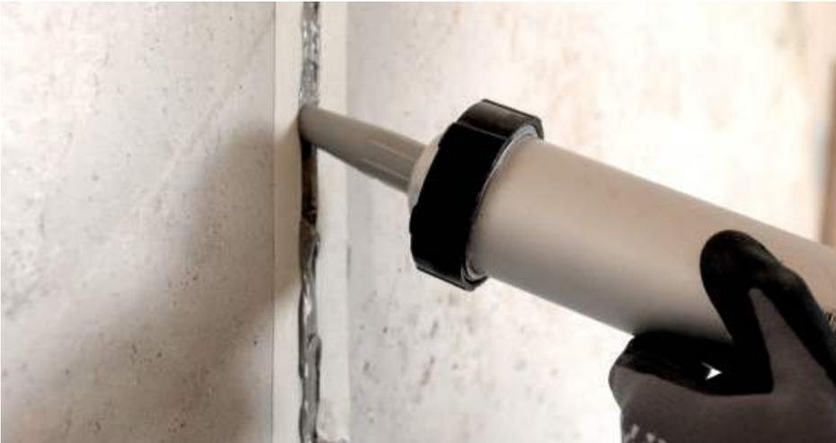
**InnoElast® Tipo 1** se inyecta en la junta
