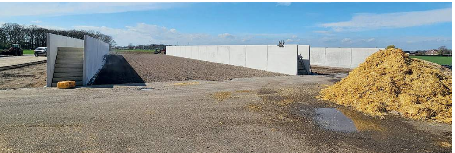
Abgedichtetes Fahrsilo in Issum
