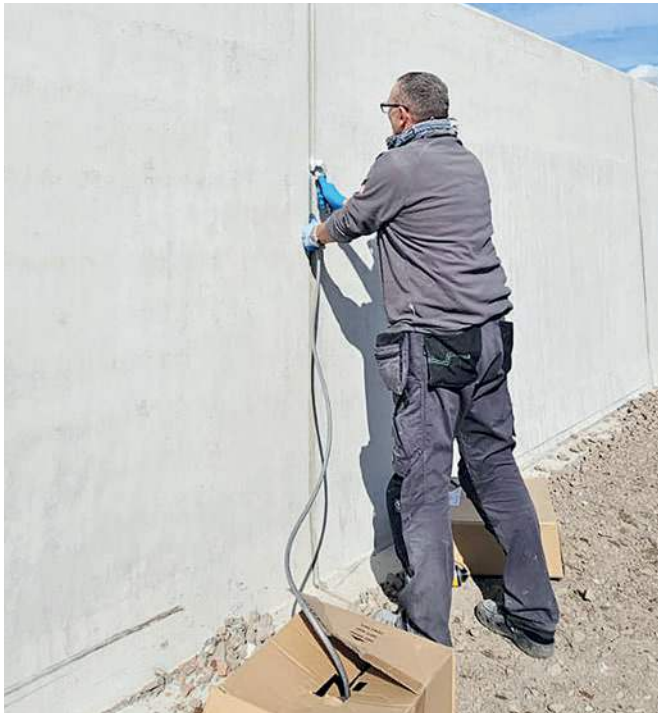
Hinterfüllschnur einfügen
