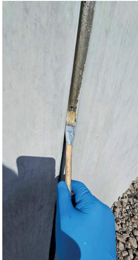
Fuge wird mit Primer Beton behandelt.
