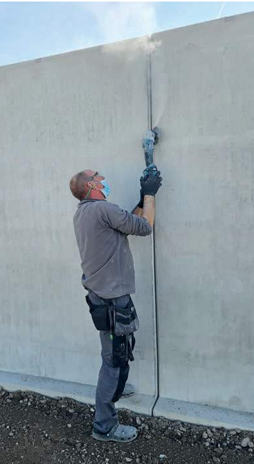
Winkliges Anschleifen der Betonfuge
