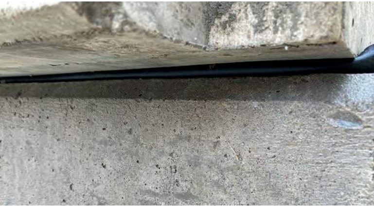
Bande d'étanchéité RubberElast mise en place et compressée
