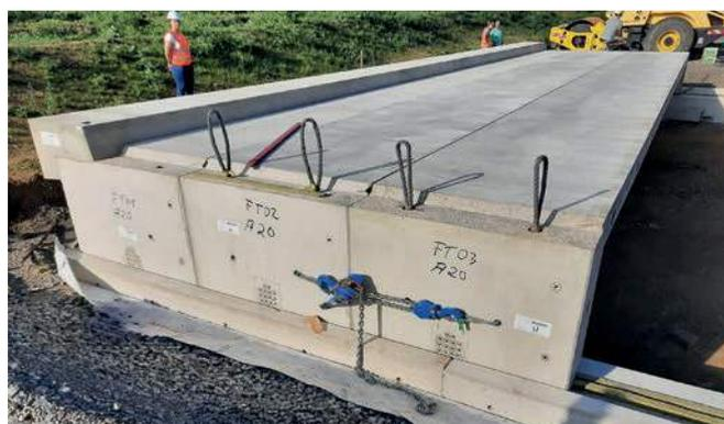
*Assemblage préalable à l'aide de palans à chaîne*
