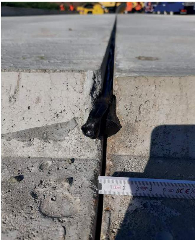
Bande d'étanchéité RubberElast avant le serrage transversal
