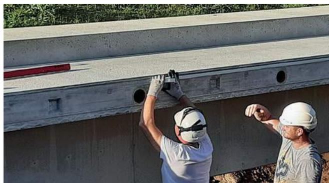
*Collage de la bande couvre-joint à pincer RubberElast*
