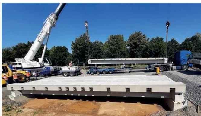
*Mise en place de l'élément préfabriqué suivant*
