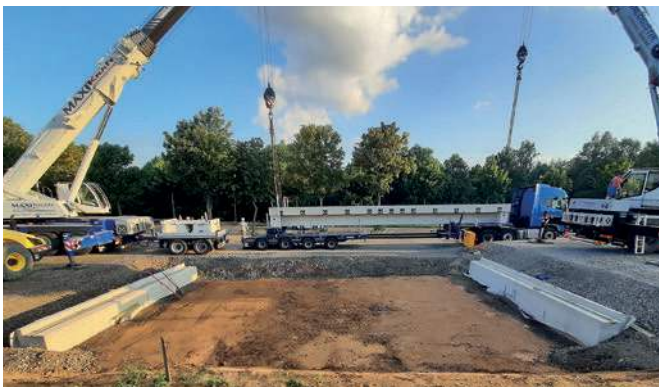
El primer elemento prefabricado es colocado sobre los estribos
