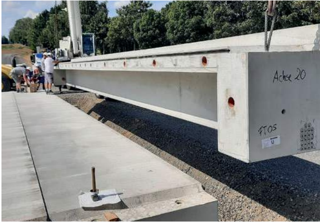
Colocación del último elemento prefabricado
