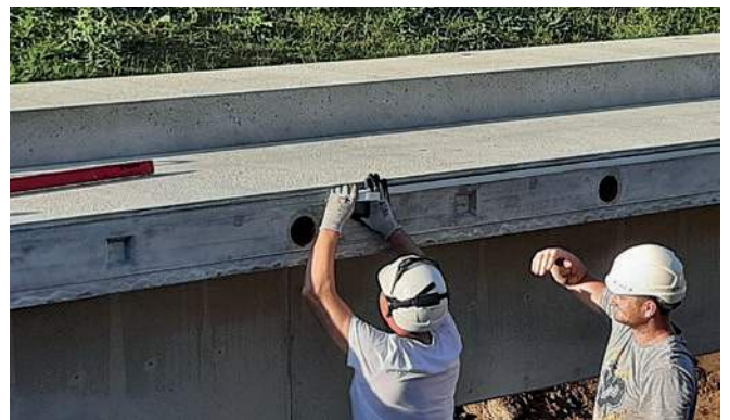
Aplicación de la banda de impermeabilización RubberElast
