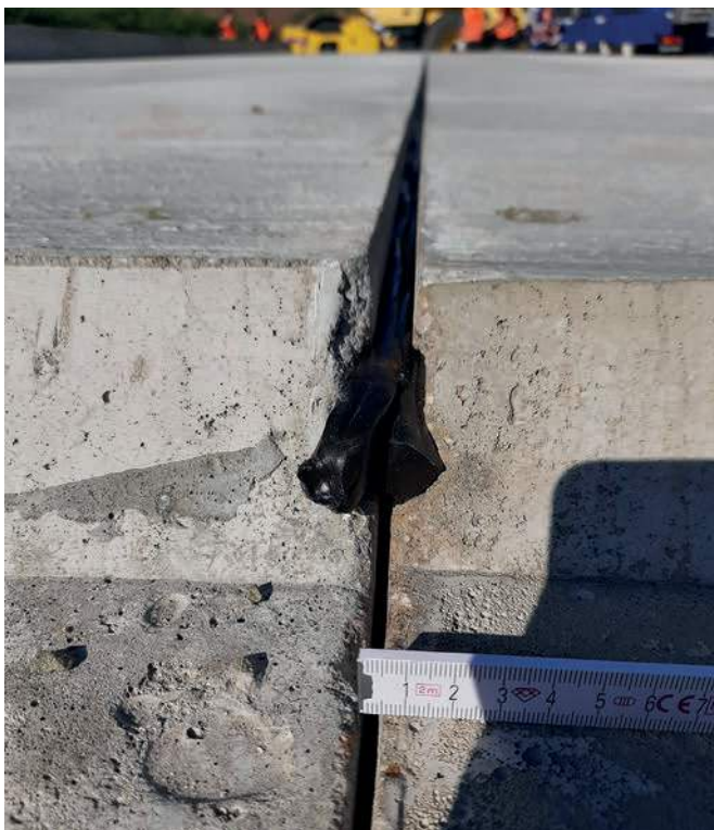
RubberElast antes del tensado transversal
