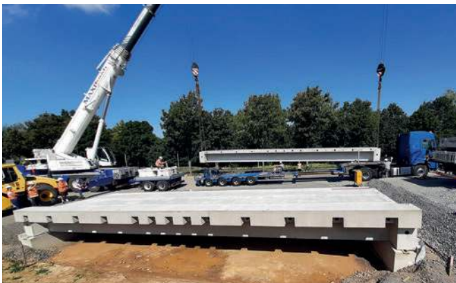
Colocación del siguiente elemento prefabricado
