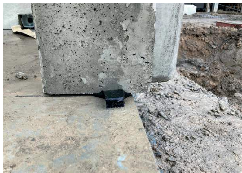
Impermeabilización con RubberElast
