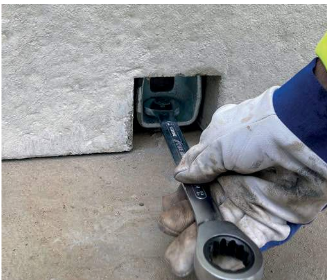
Montaje del tensor BT-Spannschloss
