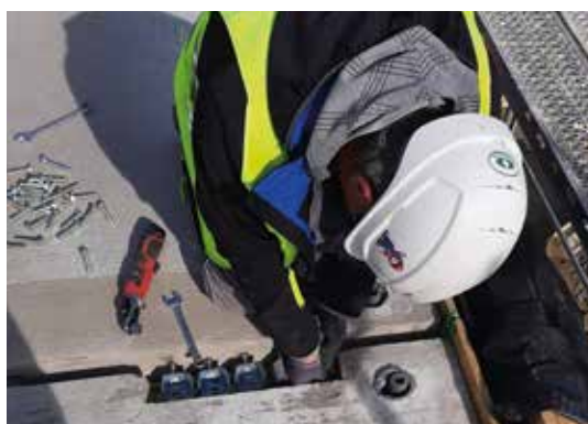
Abb. 6 (Bild oben) Einzelner PE-Aussparungskörper in der Schalung
