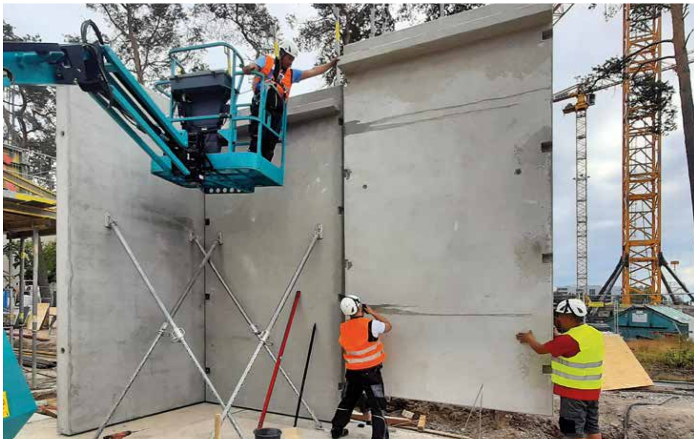
Abb. 1 (Bild oben) Wandmontage am Siemens Campus Erlangen, Verbindung der Wände mit dem BT-Spannschloss
