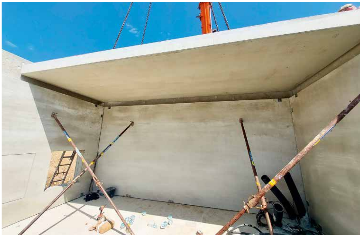
Positioning of the first floor element Auflegen des ersten Deckenelements
