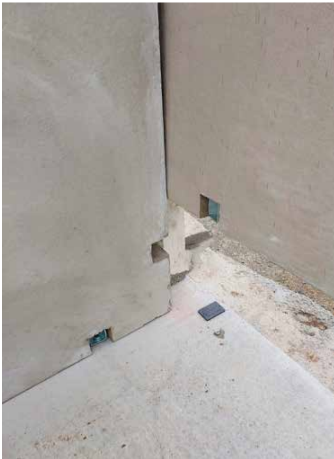
The BT-Spannschloss turnbuckle was used for the connection of the precast concrete elements on the ground slab and to each other Die Verbindung der Fertigteile mit der Bodenplatte und untereinander erfolgte mit dem BT-Spannschloss
