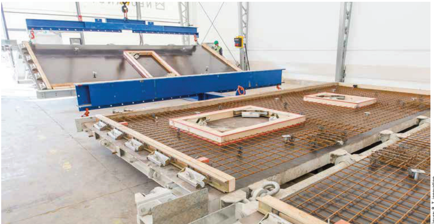
Horizontal preparation of the butterfly formwork Liegende Vorbereitung der Schmetterlingsschalung
