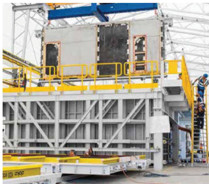
Precast wall elements smooth-formed on five sides Fünffseitig schalungsglatte Wandfertigteile im Produktionsprozess
