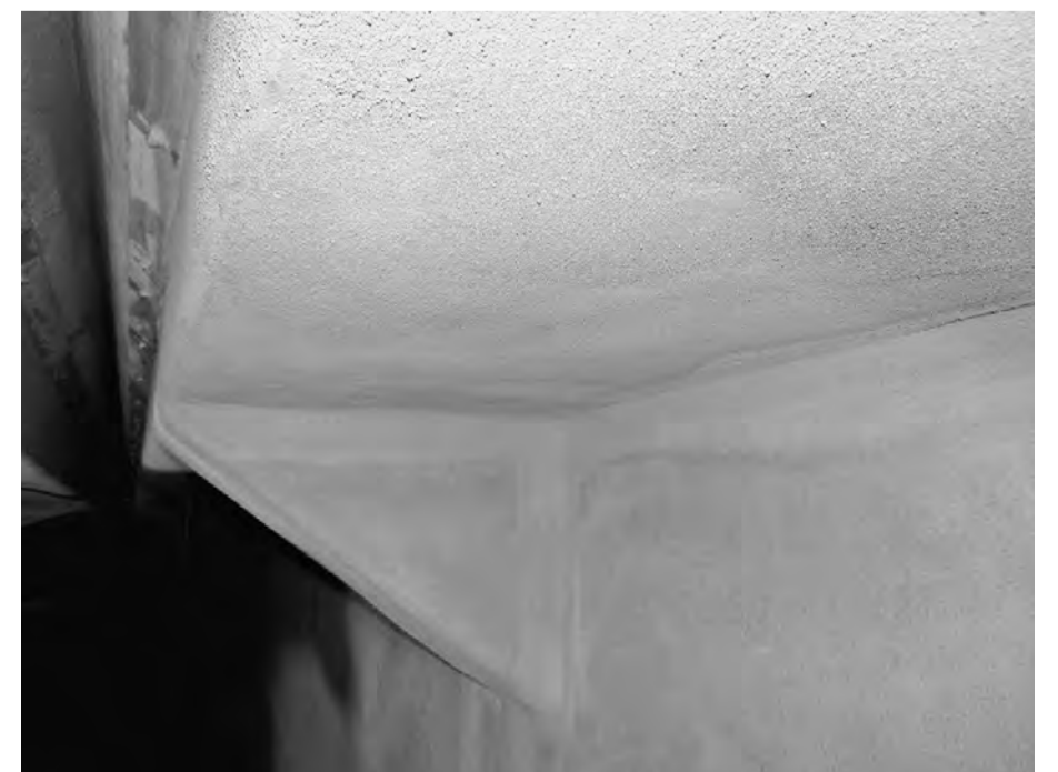
Reprofilierung mit einem sehr sulfatbeständigen Mörtel.
