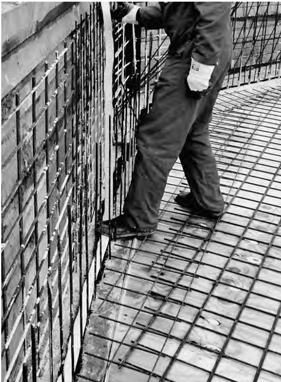
Hier entsteht ein neuer Güllekeller, der fachgerecht abgedichtet wird. FOTOS: BT INNOVATION
