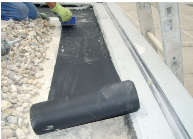
Impermeabilización del techo con el sistema ProElast®
