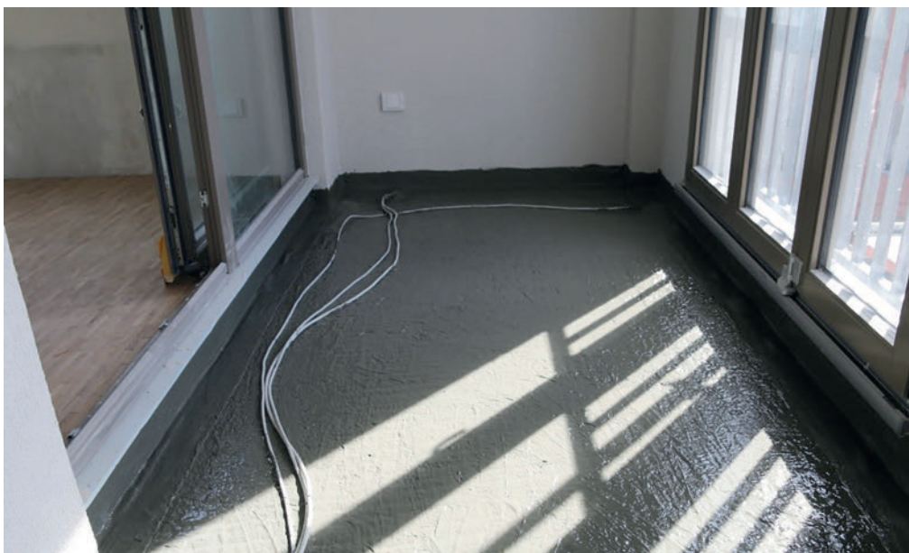
Impermeabilización de balcón con el sistema FlächenElast®
