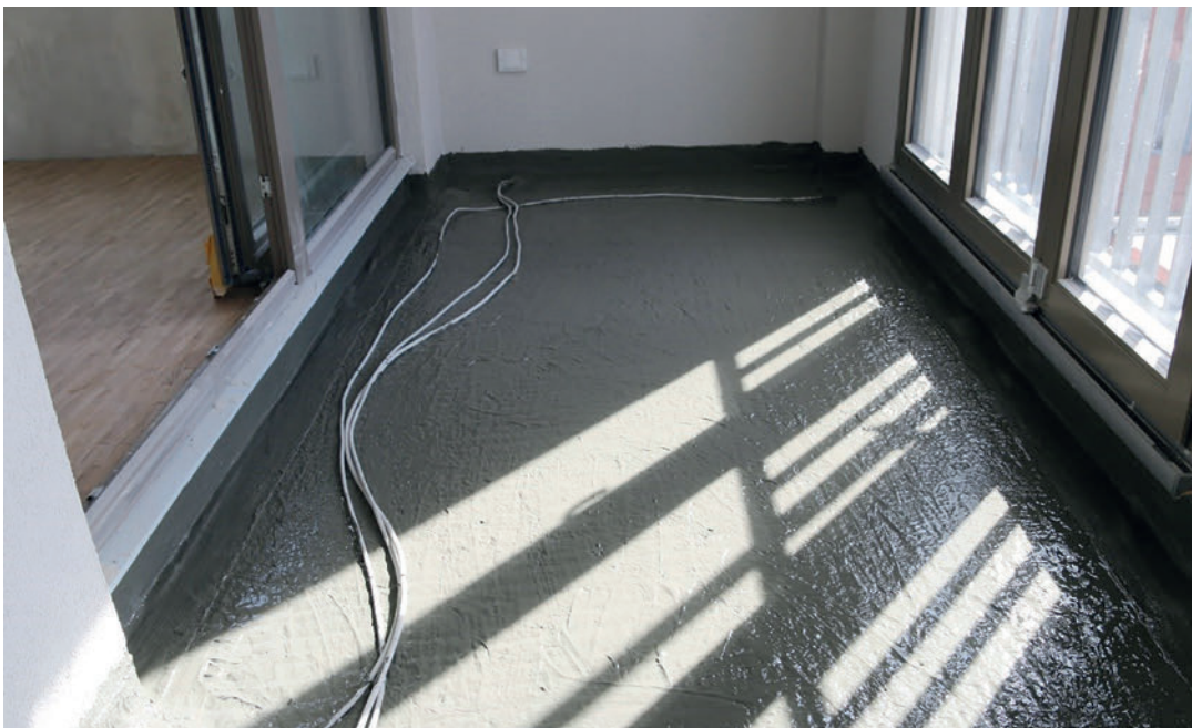
Étanchéité des balcons avec le système FlächenElast®
