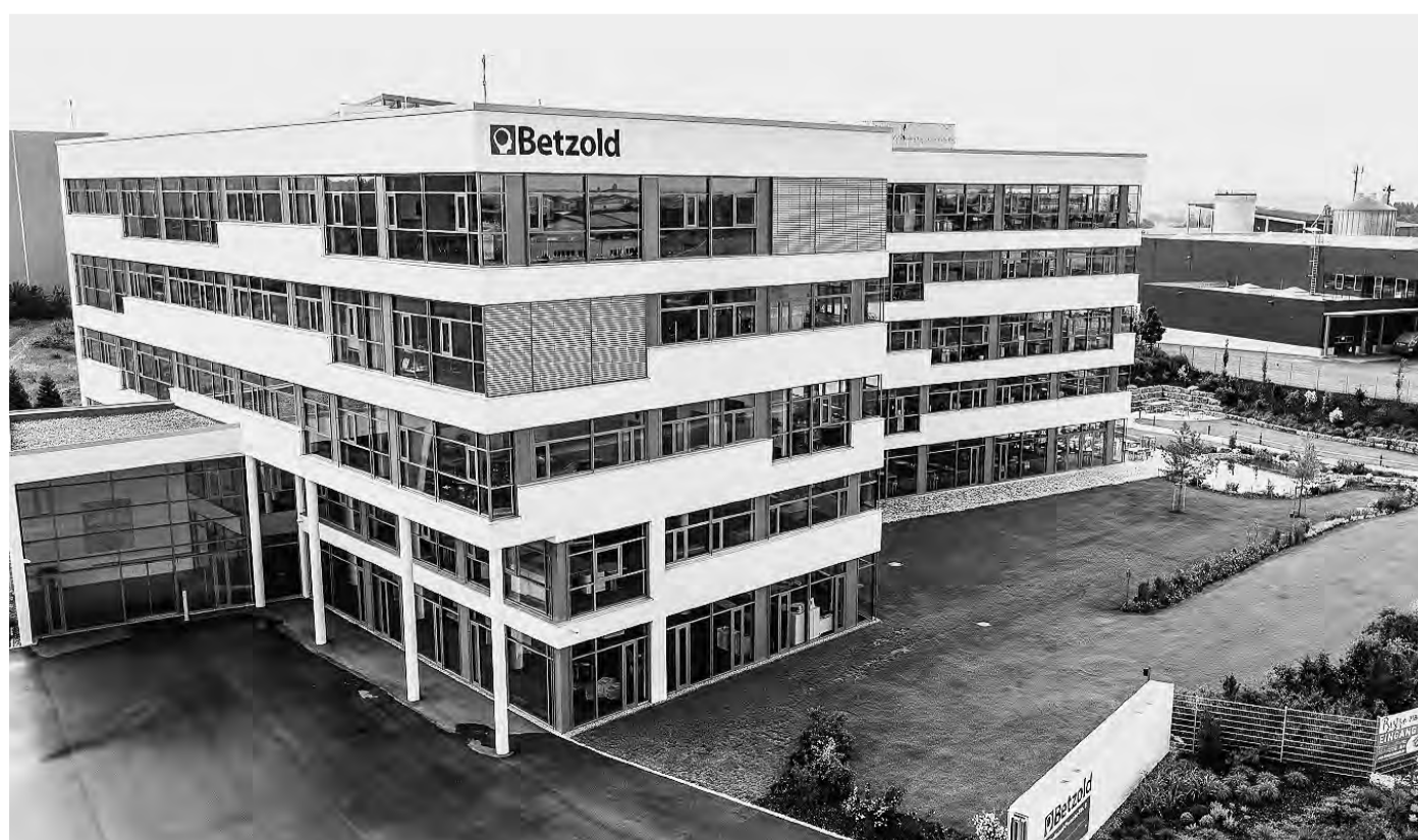
Das neue Bürogebäude der Arnulf Betzold GmbH in Ellwangen ist top-wärmedämmt und erfüllt sogar die hohen Passivhaus-Anforderungen. Highlight sei die Fassade mit Ganzglasecken und sehr langen Lichtbändern, so Joma. FOTOS: MATTHIAS MANG/JOMA DÄMMSTOFFWERK
