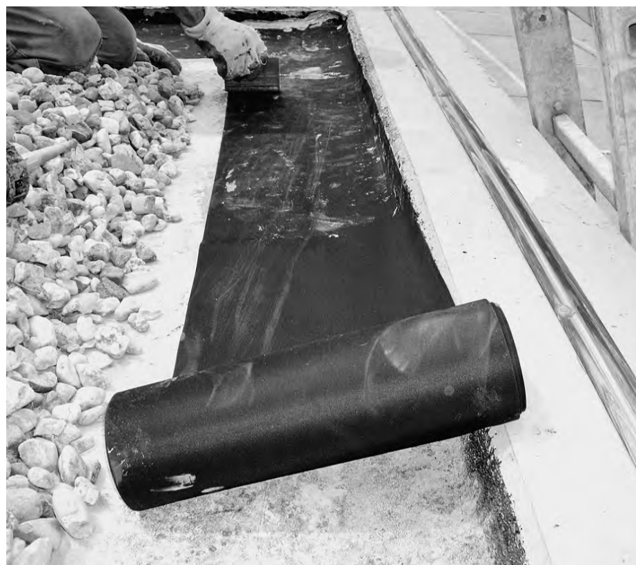
Dachabdichtung mit dem patentierten ProElast-System.
