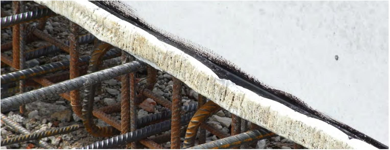
**ABDICHTUNGSBAND FÜR ARBEITSFUGEN IN BEHÄLTERN UND SILOS**
