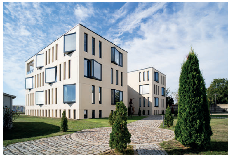
Firmengebäude B.T. innovation GmbH in Magdeburg seit 2014
