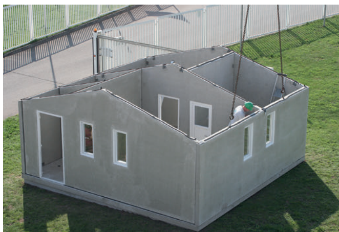
Errichtung des ersten Prototyps des Low Cost House - Aufbau in zwei Stunden
