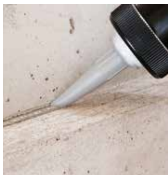
Sealing joints with InnoElast Type 2e Die Abdichtung von Fugen mit InnoElast Typ 2
